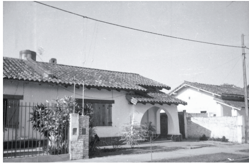
FIGURA 3 | Viviendas al presente con los componentes constructivos originales.
