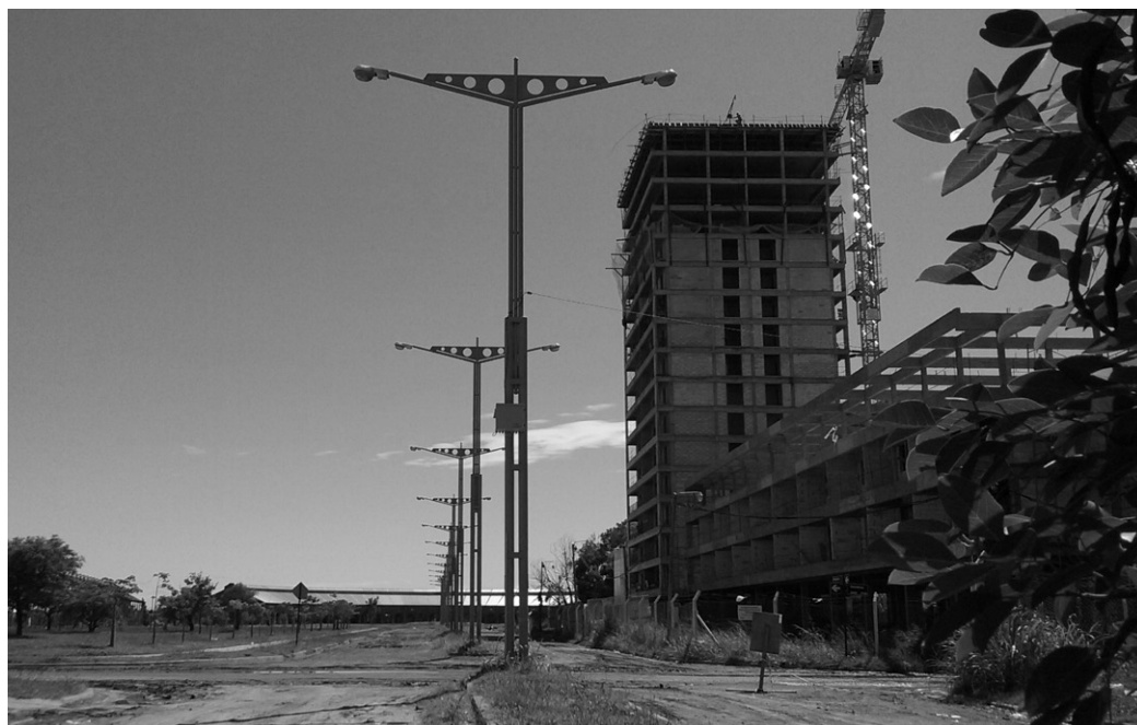
FIGURA 1 | Construcción del Proyecto Estación Santa Fe Cambios – N° 40 (Pro.Cre.Ar). Foto: Ma. Celeste Peralta Flores (29/02/2016).
