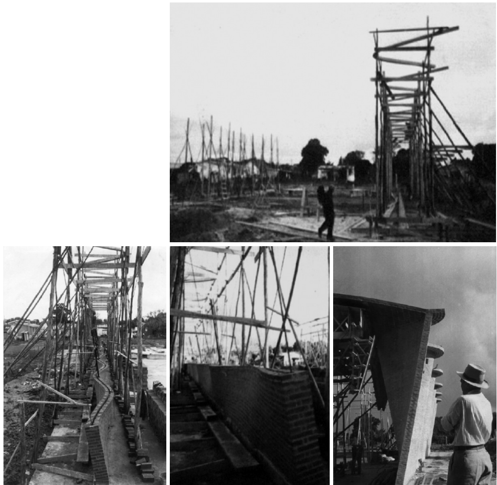
FIGURA 2-5 | Construcción de los muros. Fotos: Marcelo Sasson.
