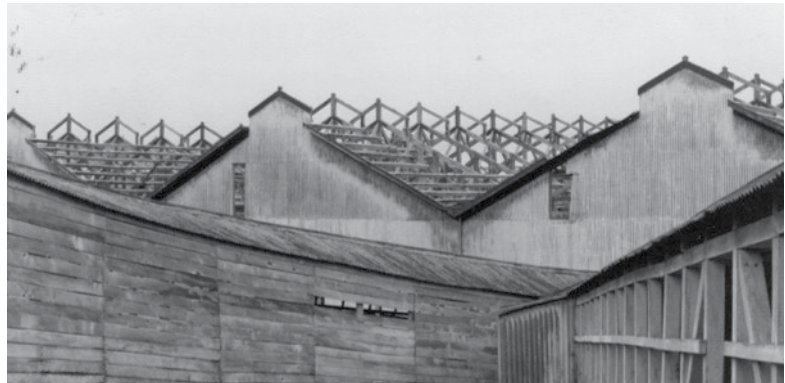
FIGURA 7A | Guías de carne y naves del Frigorífico Bories demolidas en 1996 (archivo de la investigación).
