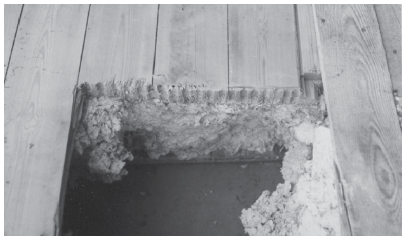
FIGURA 8 | Tabique de nave frigorífica del Frigorífico Bories 1996 (archivo de la investigación).
