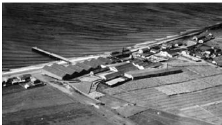
FIGURA 9 | Fotografía aérea Frigorífico Tres Puentes 1935 (www.ferrocarrilesenelconosur.co.uk).
