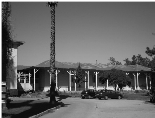
FIGURA 11 | Vista exterior de uno de los pabellones laterales del Hospital de Mercedes de Chimbarongo. Imagen: Unidad de Patrimonio Cultural de la Salud.
