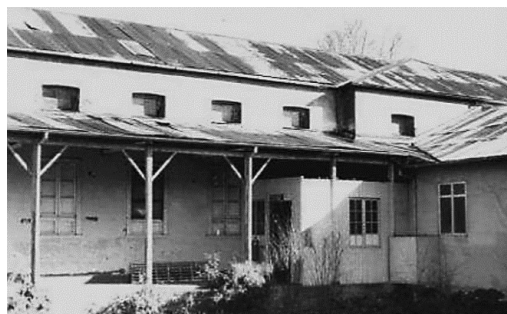
FIGURA 4 | Vista de volúmenes del Hospital San Juan de Dios de San Fernando desde patio posterior. Imagen: Ministerio de Salud.
