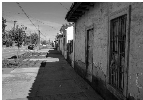
FIGURA 8 | Vista de edificaciones de tipología continua en calle vMiraflores. Fachada norte. Imagen: Alicia Campos G.
