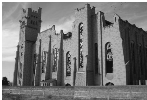
FIGURA 11 | Imagen actual. Fachada noroeste. Fuente: anónima.
