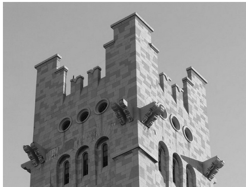
FIGURA 7 | Imagen actual. Detalle del remate de la torre. Fuente: fotografías de Daniel Prado.
