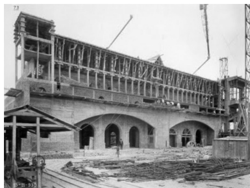
FIGURA 3 | La usina en construcción: Fachada principal, pseudo-loggia del primer piso. Fuente: Archivo Museo Ferro-White.
