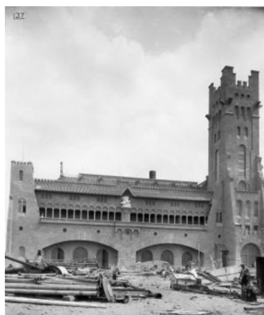
FIGURA 4 | La usina en construcción: Fachada principal concluida. Fuente: Archivo Museo Ferro-White.
