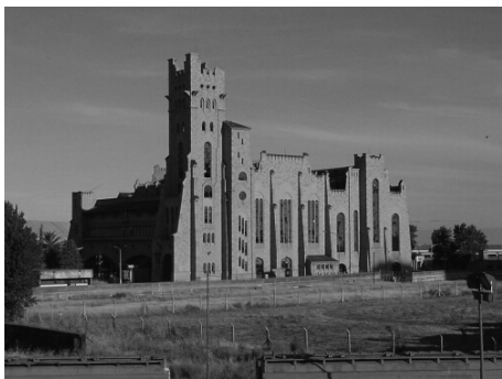
FIGURA 10 | Imagen actual. Fachada Noroeste. Fuente: anónima.
