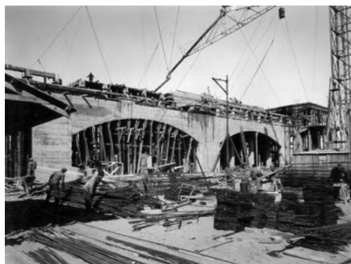
FIGURA 2 | La usina en construcción: Fachada principal, arcos de planta baja. Fuente: Archivo Museo Ferro-White.
