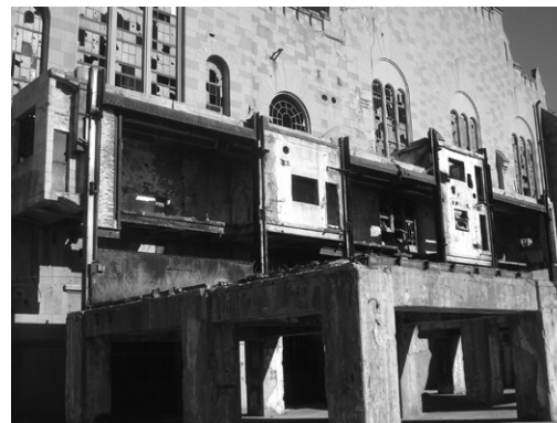
FIGURA 13 | Imagen actual. Fachada sudeste. Fuente: fotografías de propia autoría.
