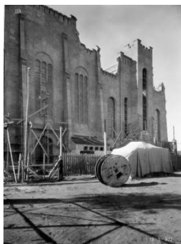
FIGURA 9 | La usina en construcción: Fachada noroeste. Fuente: Archivo Museo Ferro-White.
