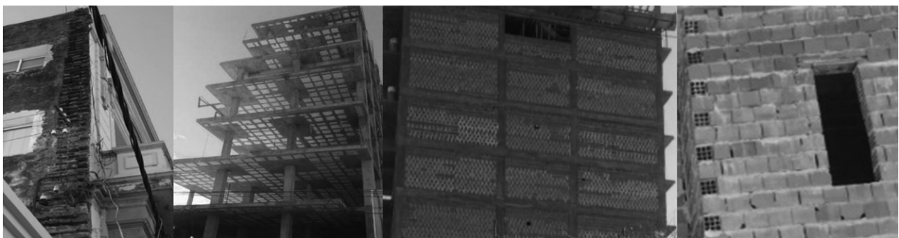
FIGURA 9 | Edificios en altura en el NEA: hasta 1960 perímetros macizos (izquierda). Desde 1970, con esqueletos estructurales. Desde 1980, con cerramientos de ladrillos huecos y losas alivianadas (derecha). Bajo las acciones climáticas regionales: la temperatura del aire y del viento intenso. Cerramientos constructivos perimetrales (abajo derecha), sin sellado de las juntas verticales de los mampuestos huecos, quedando secciones transversales con aire y solamente selladas por los revoques y superficiales. Fuente: Jacobo, 2016; 2017.
