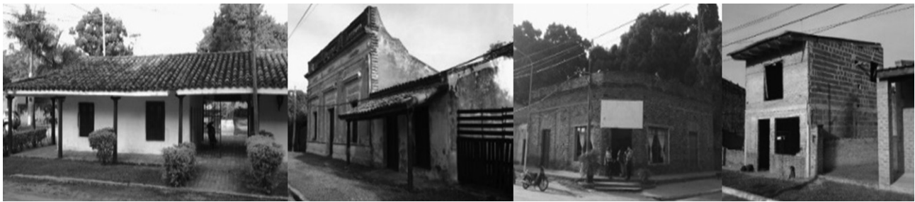
FIGURA 8 | Ejemplo de la evolución en los últimos 100 años de la edificación en el NEA: de construcciones con adobe y madera (izquierda) a las de cerámicos huecos, chapas y vidrio (derecha). De altas a bajas resistencias térmicas perimetrales de la edificación regional. Fuente: Jacobo, 2016; 2017.
