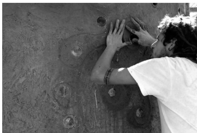
FIGURA 7 | Bioconstrucción con barro y botellas. Fuente: Shamballa (2013).
