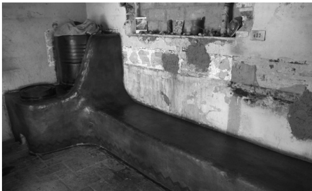
FIGURA 4 | Estufa de alto rendimiento tipo «Rocket». Fuente: Di Bernardo (2017).
