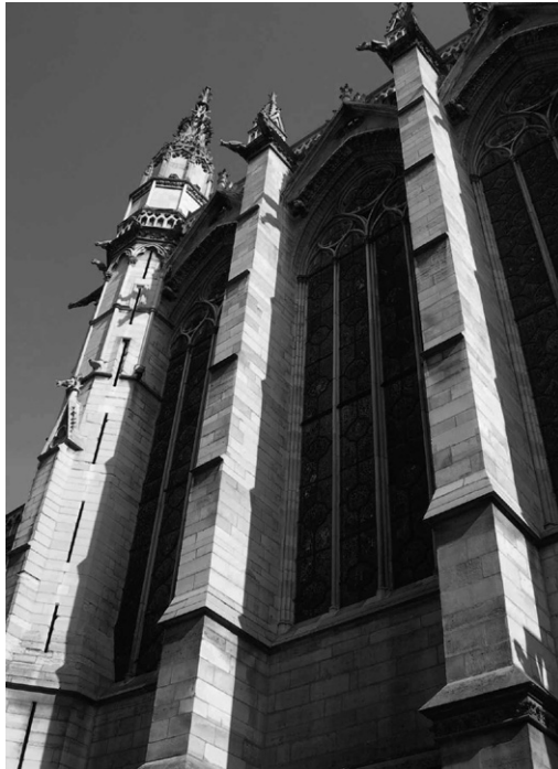
FIGURA 10 | Contrafuertes exteriores. Fuente: Archivo del autor.
