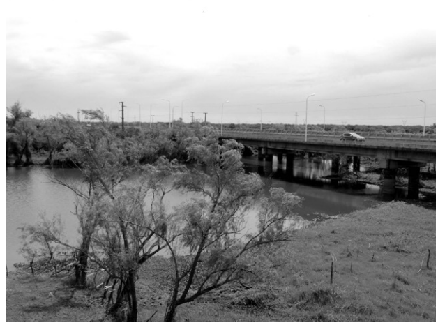
FIGURA 7 | Arriba: vista del puente cortado; abajo: vista desde el puente cortado. Fuente: Santiago, 2018.
