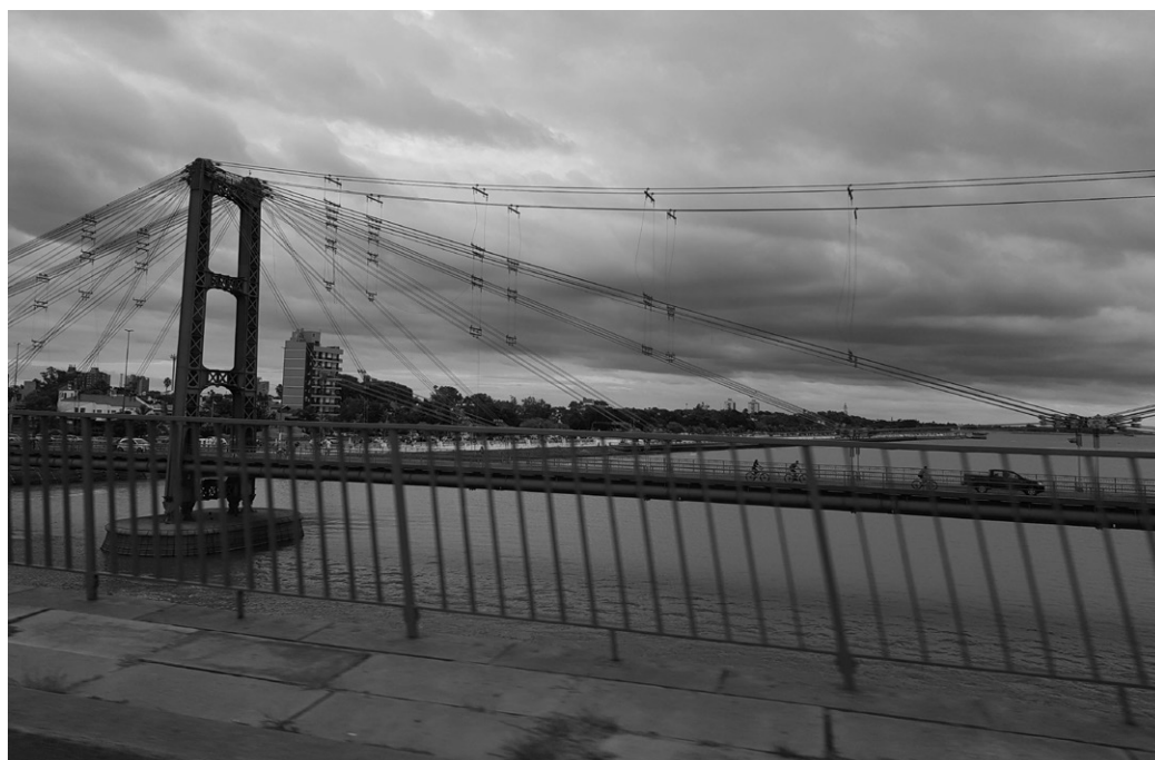
FIGURA 3 | Vista del Puente Colgante desde el viaducto Oroño. Fuente: Santiago, 2018.
