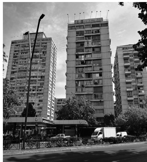
FIGURA 1 | Torres de Tajamar. Fuente: Archivo de los autores, 2019.
