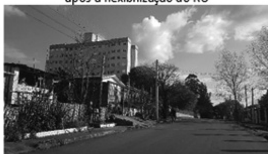
d) Setor 8, área do edifício gravada como ZE, após a flexibilização do RU
