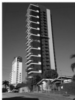
a) Setor 15, próxima a área central, gravada como ZOI-2
