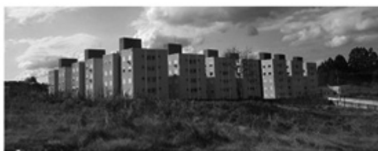
c) Setor 8, área do edifício gravada como ZEIS-1, após a flexibilização do RU
