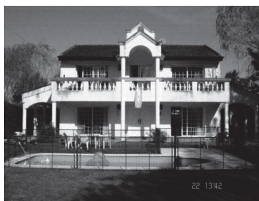
Figura 10 | Viviendas en el área urbanizada sobre el valle de inundación, 2008.
