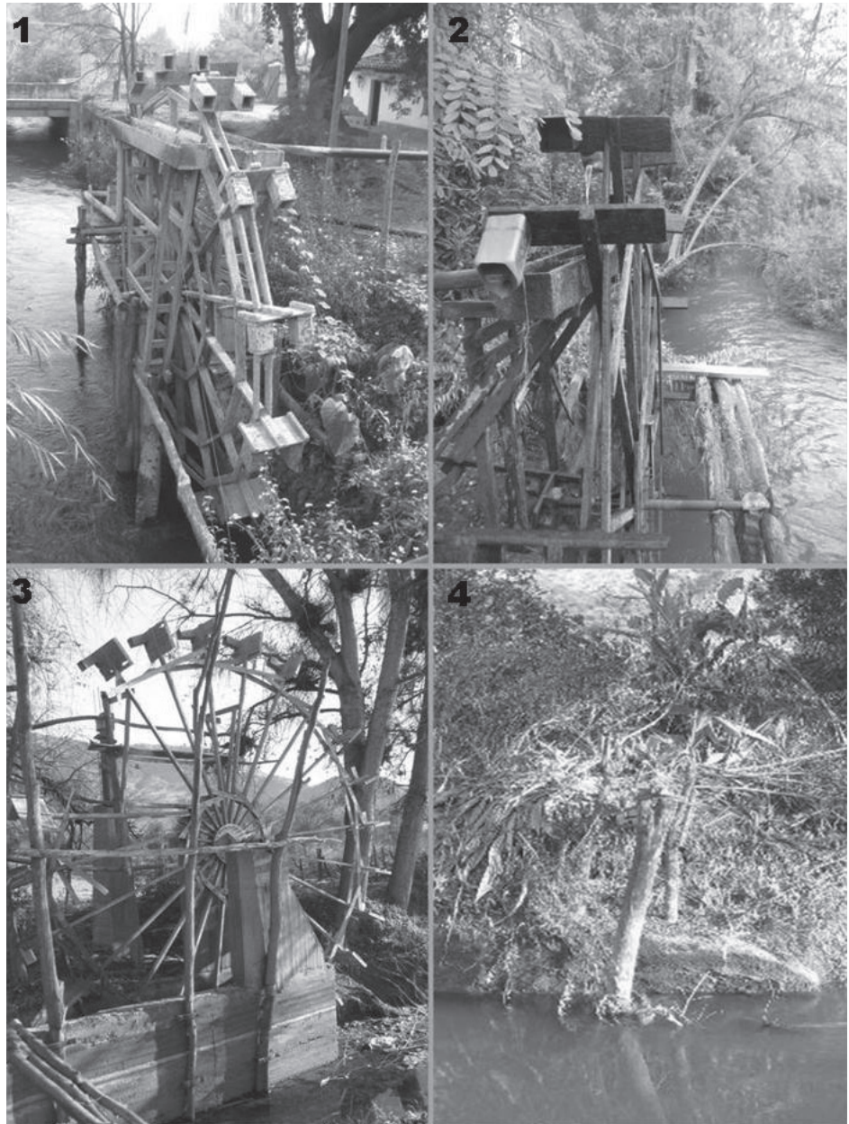
FIGURA 121 Aplicación del Esquema Evolutivo del Estado de Conservación a las Azudas de Larmahue. 1) Rueda Original (Iván Urzua). 2) Rueda Intervenida (Pedro Fuentes). 3) Rueda Abandonada (Otilia Zamorano). 4) Rueda destruida (Pedro Matus). IHP, 2011.
