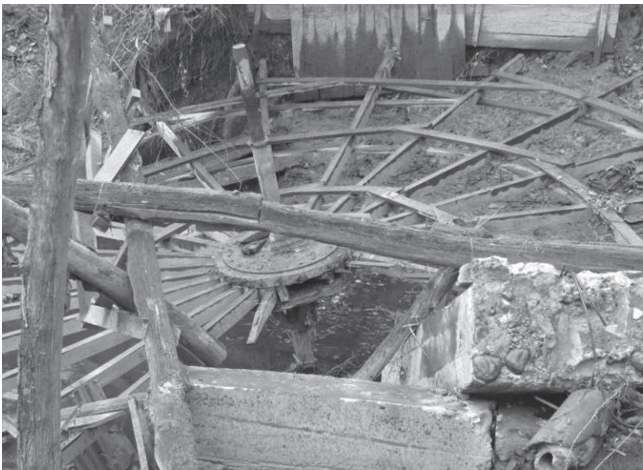
FIGURA 131 Rueda de agua destruida por sismo del 27 de febrero de 2010, en la localidad de Larmahue. IHP, 2011.
