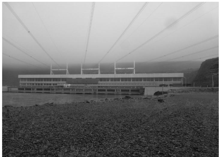
FIGURA 7 | Vista general, central hidroeléctrica Chocón–Cerro Colorado (1968). Créditos: Camila Costa (2019).
