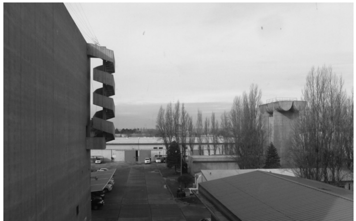
FIGURA 6 | Sala de calderas, laboratorios y tanque de agua, Central termoeléctrica Alto Valle (Llauró–Urgell, 1964) Créditos: Camila Costa (2019).
