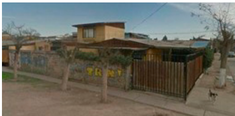
POLÍGONO 6: SECTOR AV. AEROPUERTO.
