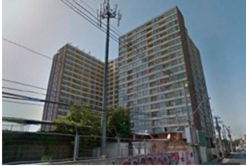
POLÍGONO 1: EDIFICIO WENCESLAO SÁNCHEZ
