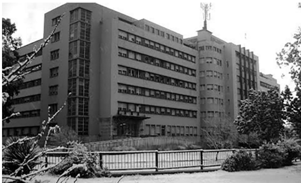
FIGURA 5 | Imagen del Hospital Central (1944), caracterizado por ventanas alargadas y esquina vidriada típicas del racionalismo. Fuente: fotografía de la autora.
