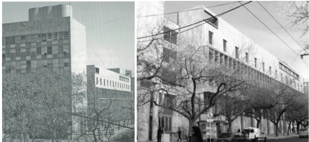
FIGURA 7 | Imágenes del Correo Central, donde se puede ver el tanque sinuoso en altura (imagen a la izquierda) y la modulación de los parasoles (imagen a la derecha). Fuente: Ponte (2008:487).
