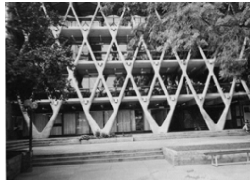
FIGURA 9 | Edificio de la Facultad de Arquitectura de la Universidad de Mendoza, estructura a la vista que evoca figuras humanas enlazadas. Fuente: fotografía de la autora.
