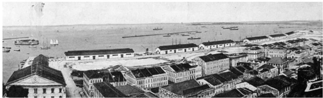
FIGURA 4 | Detalhe do panorama acima. Observa-se que os sete primeiros armazéns já estavam construídos, e que a grande faixa de aterro entre o porto e o bairro não havia sido arruada.
