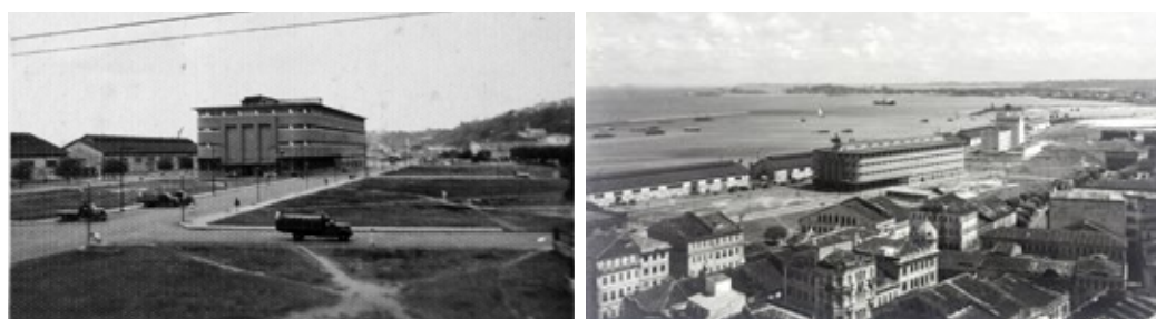
FIGURA 15 y 16 | O edifício-sede do Instituto de Cacau da Bahia, provavelmente no final dos anos 1930. Notar o isolamento do edifício e o contraste de suas formas com os edifícios do bairro consolidado. Acervo Museu Tempotal.
