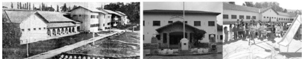
FIGURA 3 | (izquierda): Escuela Hogar. Provincia de Mendoza. Función actual: museo histórico. Fuente: http://www.google.com/images/mendozahogarescuela . Figura 3 (centro y derecha): Escuela Hogar. Provincia de Salta. Función actual: hogar–escuela. Fuente: http://190.224.160.133:8080/salta/Salta/diario/2011/02/28/salta/
