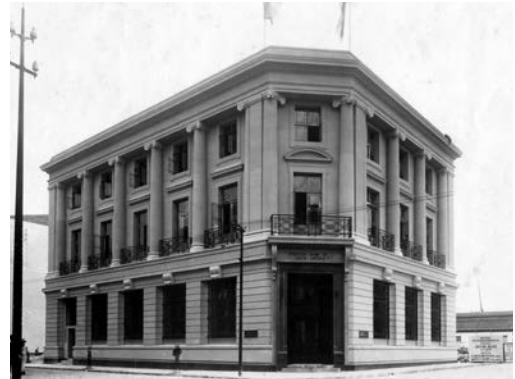
FIGURA 12 | Foto do edifício, à época da construção. Notar que não havia nada em volta. Tratava-se de uma construção pioneira, que ficava completamente isolada nos novos terrenos. Ao fundo, o Armazém Nº 2 do novo porto. Acervo Carioca Christiani & Nielsen Engenharia.
