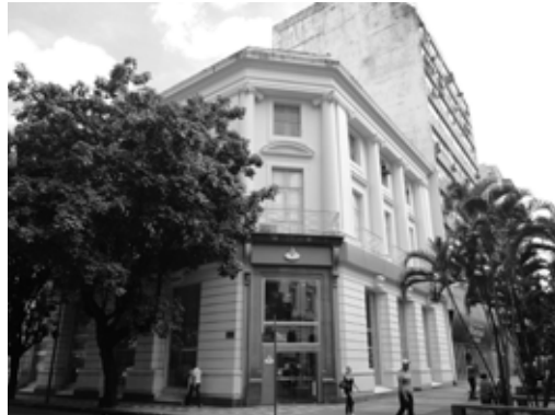
FIGURA 11 | Edifício do The British Bank of South America à Rua Miguel Calmon Nº 18, esquina com a Praça da Inglaterra. Foto: Paula De Paoli, 17/07/2013.
