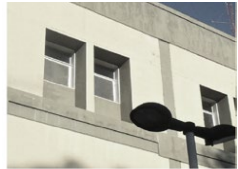
FIGURA 11 | Exterior Sector Nuevo. 03/07/2013 9:16:00. Fuente: Alias et al. (2013b).
