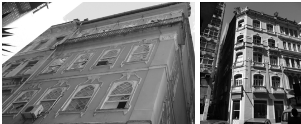
FIGURA 9 y 10 | Sobrado à Rua Conselheiro Dantas Dantas s/n, com fundos para a Rua Conselheiro Saraiva e fachada lateral para um beco sem nome. Apenas a fachada para a Rua Conselheiro Dantas (Fig. 10) foi remodelada, ao passo que as demais permaneceram como eram (Fig. 9). Notar a diferença entre os repertórios formais nas duas fachadas. Fotos: Paula De Paoli, 24/07/2013.
