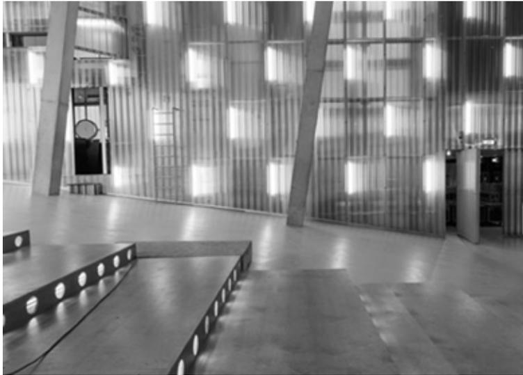
**FIGURA 8** | Muro lateral del auditorio de policarbonato. Kunsthall, Rotterdam.
