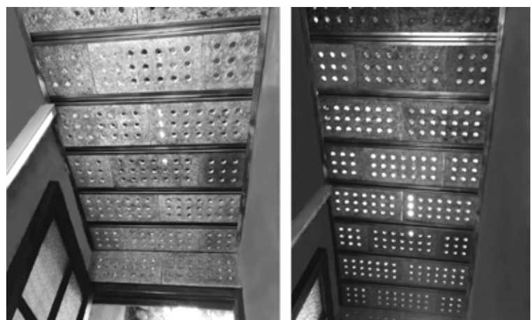
FIGURA 4 | Cielorraso de placas perforadas de papel cemento. Fuente: Arq. Caruso.
