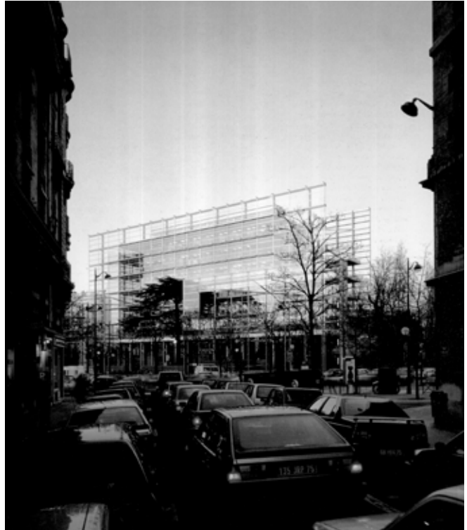
FIGURA 6 | Fundación Cartier. Arq. J. Nouvel. Fuente: Light Construction . Transparencia y ligereza en la arquitectura de los 90 . T. Riley, GG, Barcelona, 1996.
