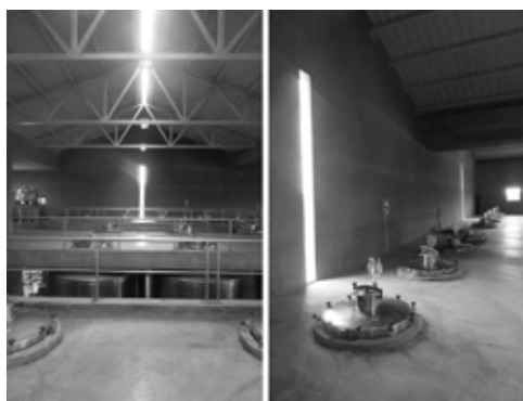
FIGURA 5 | Sector de producción y almacenaje en la planta superior. Fuente: autora.
