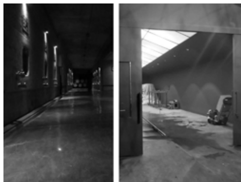
FIGURA 2 | Iluminación artificial y natural del sector de almacenaje de almacenaje de la Bodega Pulenta. Fuente: autora.
