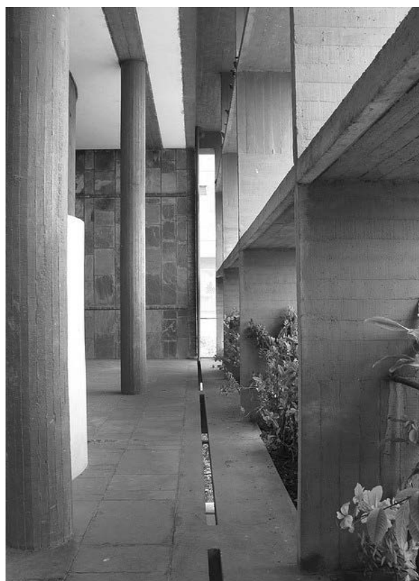
FIGURA 13 | La Asociación de Hilanderos de Ahmedabad. Brise-soleil de la fachada este, como elemento compositivo (que soporta los elementos vegetales) visiblemente separado de la fachada. Fuente: acervo de los autores.
