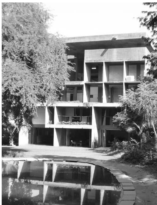
FIGURA 12 | Villa Shodan. Vista de la fachada SO y la distribución no uniforme de los brises. Fuente: acervo de los autores.
