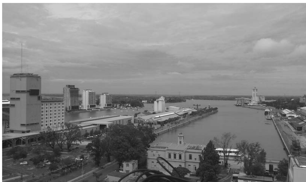
FIGURA 3 | Construcciones recientes en el área portuaria de Santa Fe habilitadas por el cambio de uso. Foto: Ma. Celeste Peralta Flores (29/02/2016)
