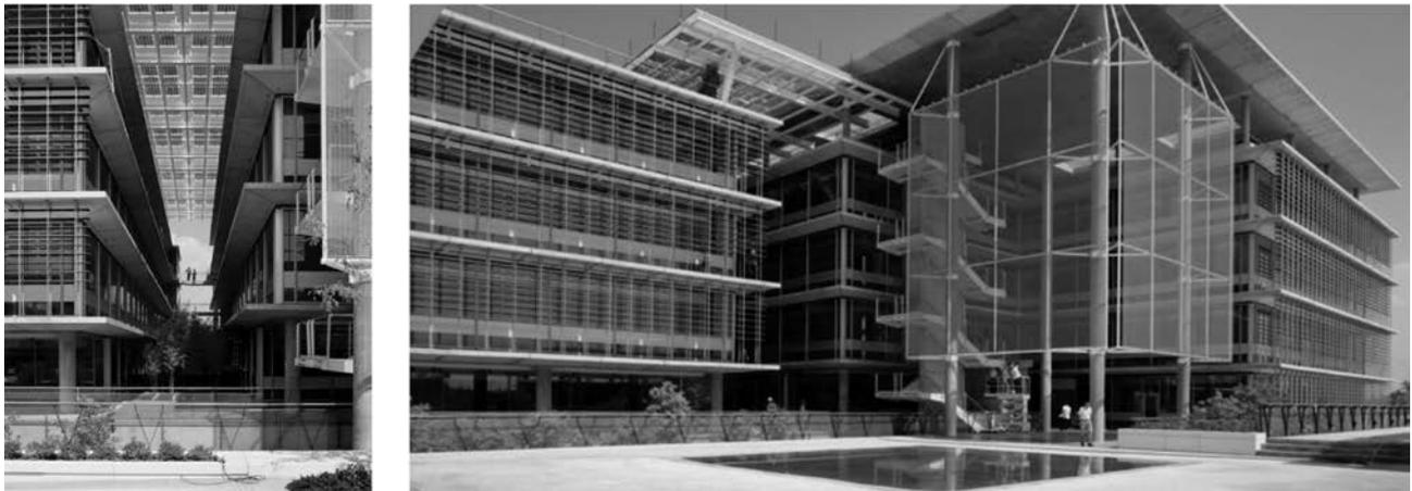
**FIGURA 7** | A la izquierda, detalle de la cubierta fotovoltaica sobre un espacio semicubierto. A la derecha, se observan el tratamiento diferencial de las envolventes de acuerdo a la orientación. *Fuente:* <https://www.rsh-p.com/projects/campus-palmas-altas/>
