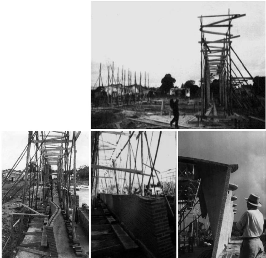
FIGURA 2-5 | Construcción de los muros. Fotos: Marcelo Sasson.
