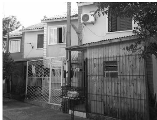
FIGURA 12 | Tipologia habitacional sobrado. Pátio da unidade habitacional sobrado. Fonte: acervo pessoal (2014).
