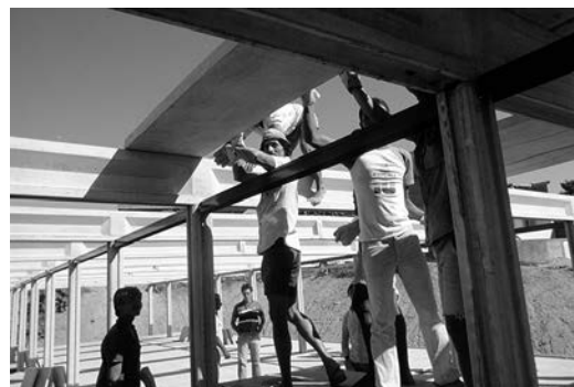
FIGURA 6 | Montagem das creches e escolas de argamassa armada em bairros de Salvador (s/d e especificação do local). Fonte: Acervo Instituto João Filgueiras Lima.
