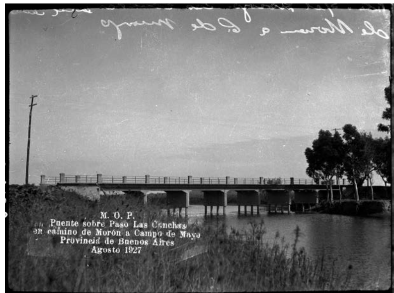
FIGURA 2 | Puente sobre el río Reconquista en el camino entre Morón y Campo de Mayo, 1927 (documento perteneciente al archivo del Centro de Documentación e Investigación de la Arquitectura Pública —CeDIAP— del CDI del Ministerio de Hacienda y Finanzas Públicas).1998).
