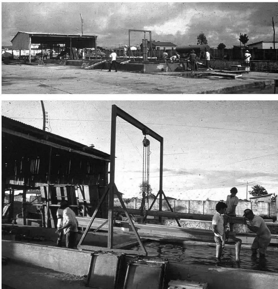
FIGURA 3 | Fábrica de Abadiânia, Goiás, 1982 (?). Fonte: Instituto João Filgueiras Lima.
