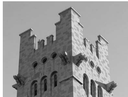
FIGURA 7 | Imagen actual. Detalle del remate de la torre. Fuente: fotografías de Daniel Prado.
