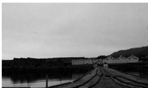
FIGURA 11 | Frigorífico Bories en demolición, 1996 (archivo de la investigación).
