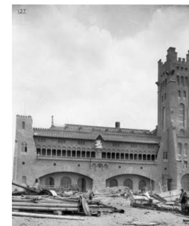
FIGURA 4 | La usina en construcción: Fachada principal concluida. Fuente: Archivo Museo Ferro-White.
