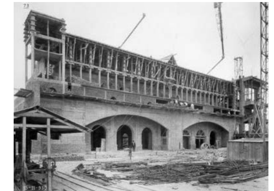
FIGURA 3 | La usina en construcción: Fachada principal, pseudo-loggia del primer piso. Fuente: Archivo Museo Ferro-White.
