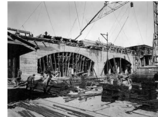
FIGURA 2 | La usina en construcción: Fachada principal, arcos de planta baja. Fuente: Archivo Museo Ferro-White.
