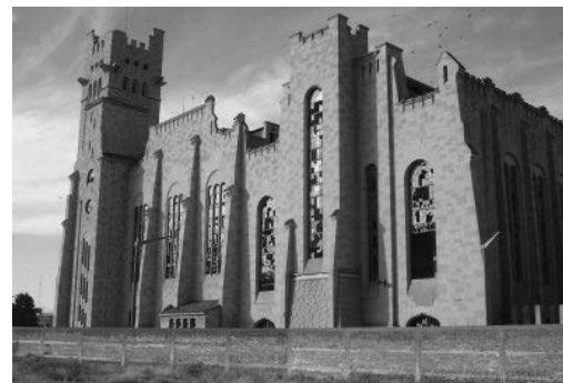
FIGURA 11 | Imagen actual. Fachada noroeste. Fuente: anónima.
