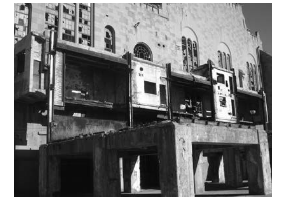
FIGURA 13 | Imagen actual. Fachada sudeste. Fuente: fotografías de propia autoría.
