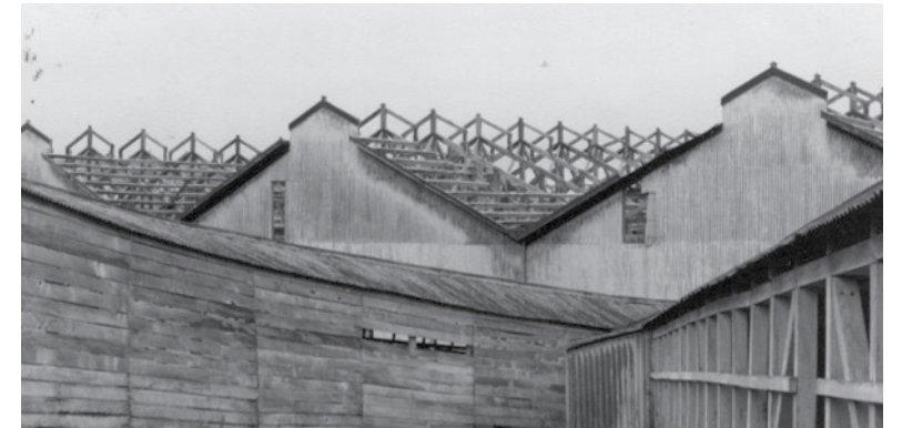
FIGURA 7A | Guías de carne y naves del Frigorífico Bories demolidas en 1996 (archivo de la investigación).
