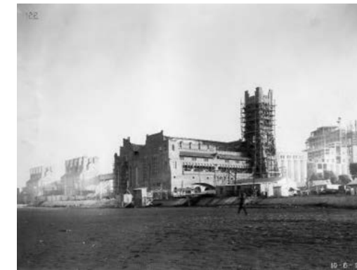
FIGURA 12 | La usina en construcción. Fachada sudeste. Fuente: Archivo Museo Ferro-White.
