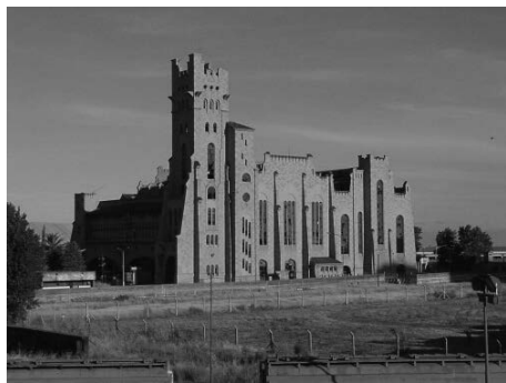
FIGURA 10 | Imagen actual. Fachada Noroeste. Fuente: anónima.
