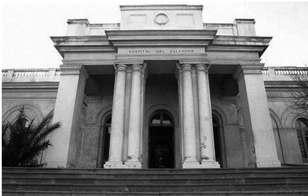
FIGURA 2 | Fachada del Hospital El Salvador. Imagen: Alicia Campos G.
