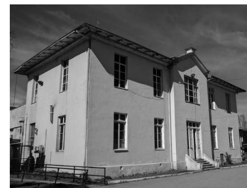
FIGURA 9 | Vista del volumen principal del Hospital de Mercedes de Chimbarongo, parte de la fachada poniente. Imagen: Alicia Campos G.
