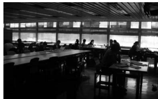
FIGURA 12 | Sala de lectura: superficies oscuras, deterioro de films aplicados a los vidrios y sistemas de protección solar, excesivos contrastes y sol directo sobre lectores, libros y mesas de trabajo. Fuente: Archivo propio.
