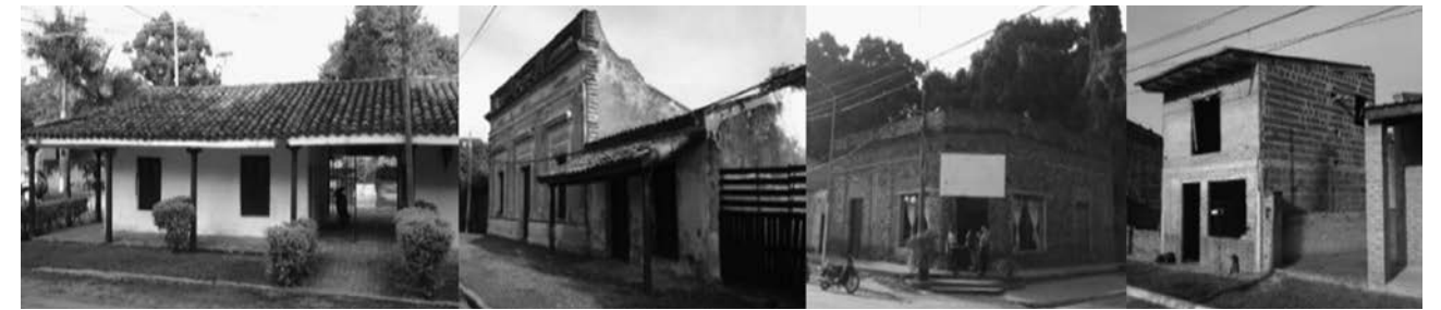
FIGURA 8 | Ejemplo de la evolución en los últimos 100 años de la edificación en el NEA: de construcciones con adobe y madera (izquierda) a las de cerámicos huecos, chapas y vidrio (derecha). De altas a bajas resistencias térmicas perimetrales de la edificación regional. Fuente: Jacobo, 2016; 2017.
