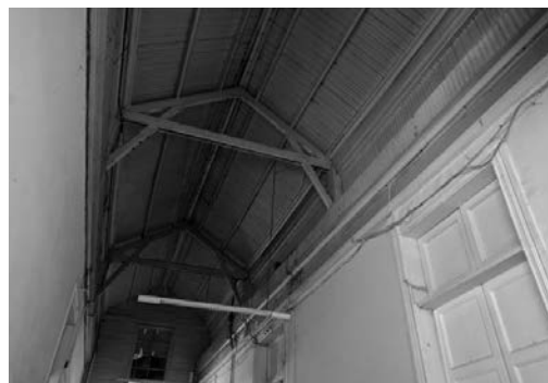
FIGURA 14 | Vista interior de la estructura de techumbre de uno de los corredores o pasillos del Hospital. Imagen: Alicia Campos G.
