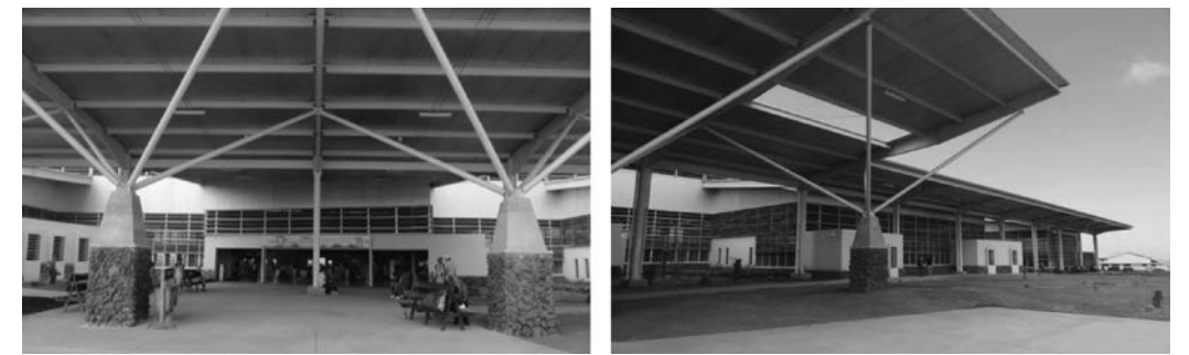
FIGURA 10 | Exterior de la Terminal de Pasajeros, Aeropuerto Ecológico Seymour, Islas Galápagos, Ecuador. Fuente: Archivo propio.
