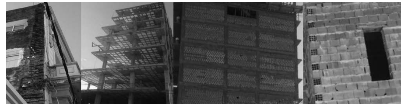
FIGURA 9 | Edificios en altura en el NEA: hasta 1960 perimetros macizos (izquierda). Desde 1970, con esqueletos estructurales. Desde 1980, con cerramientos de ladrillos huecos y losas alivianadas (derecha). Bajo las acciones climáticas regionales: la temperatura del aire y del viento intenso. Cerramientos constructivos perimetrales (abajo derecha), sin sellado de las juntas verticales de los mampuestos huecos, quedando secciones transversales con aire y solamente selladas por los revoques y superficiales. Fuente: Jacobo, 2016; 2017.
