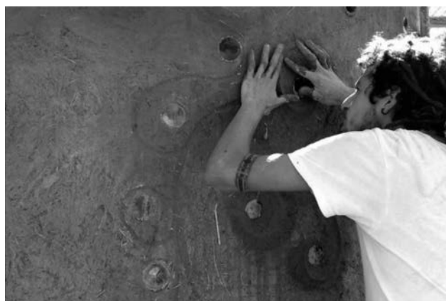
FIGURA 7 | Bioconstrucción con barro y botellas. Fuente: Shamballa (2013).
