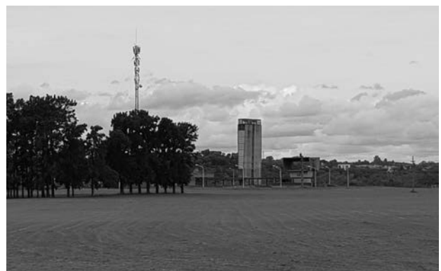
FIGURA 8 | Vista de las instalaciones del Túnel Subfluvial desde la RN N° 168. Fuente: Santiago, 2018.
