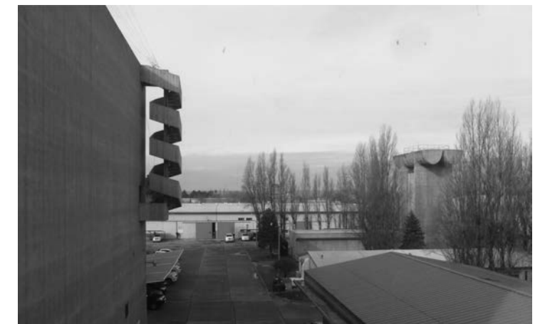
FIGURA 6 | Sala de calderas, laboratorios y tanque de agua, Central termoeléctrica Alto Valle (Llauro-Urgell, 1964) Créditos: Camila Costa (2019).
