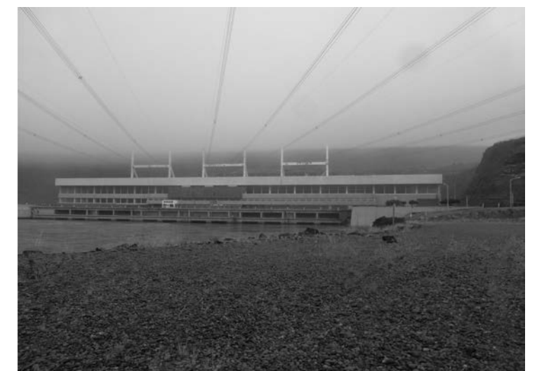
FIGURA 7 | Vista general, central hidroeléctrica Chocón-Cerros Colorados (1968). Créditos: Camila Costa (2019).
