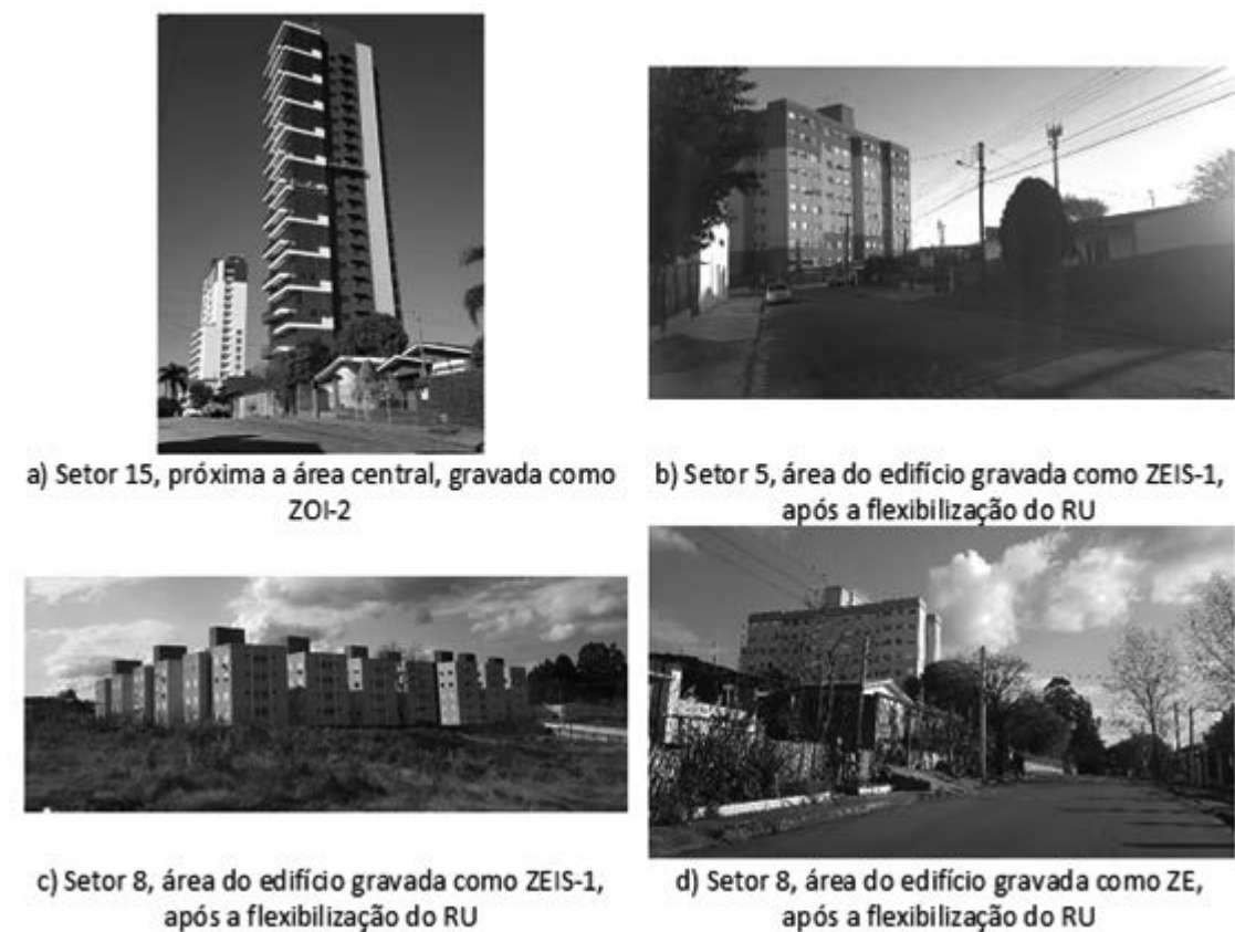
FIGURA 8 | Edificações recentes e a relação com a localização e o regime urbanístico da área. Fonte: autores (2020).
