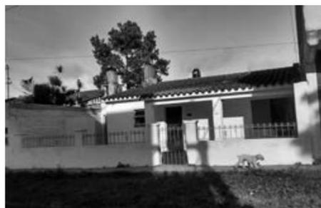
**FIGURA 10** | Imagen de las viviendas en estado original, caracterizadas por la cubierta en pendiente a dos aguas en losa de hormigón armado recubierta con tejas españolas. Fuente: colección del autor.
