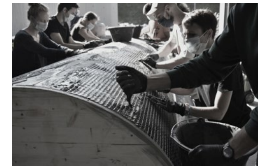
FIGURA 11 | Taller de verano «Prototype Pavilion in Textile Reinforced Concrete», 2019, EPFL Fotografía: Ana Carvalho.
