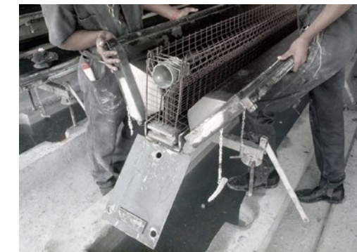
FIGURA 1 | Encofrado y armadura de piezas en argamassa armada – viga de las «Escolas Transitórias» (1988). Fuente: Instituto João Filgueiras Lima.
