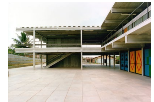
FIGURA 2 | Escuela del barrio de Nova Brasília, Salvador, Bahía, Lelé (1986). Fuente: Instituto João Filgueiras Lima.
