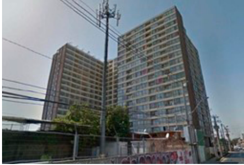
POLÍGONO 1: EDIFICIO WENCESLAO SÁNCHEZ
