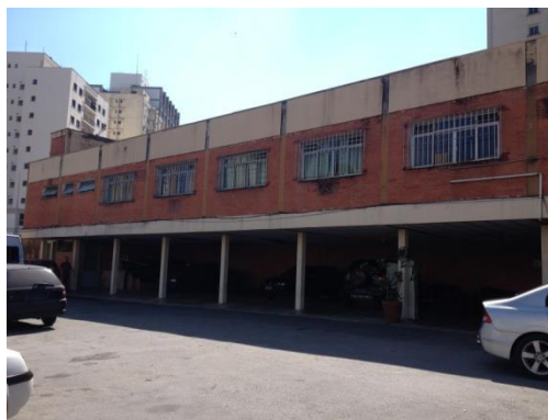
Figura 10 - Prédio de alojamento. Foto: Deborah Neves, 2017.
