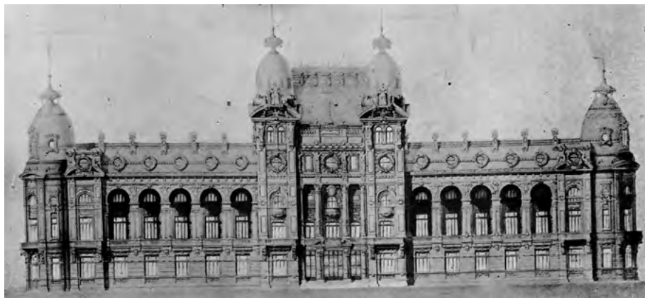
Imagen 2. Casa de Gobierno de la Provincia en construcción | Número Único | Inauguración del Puerto de Ultramar Santa Fe | 1910 | Hemeroteca Archivo General de la Pcia. De Santa Fe
