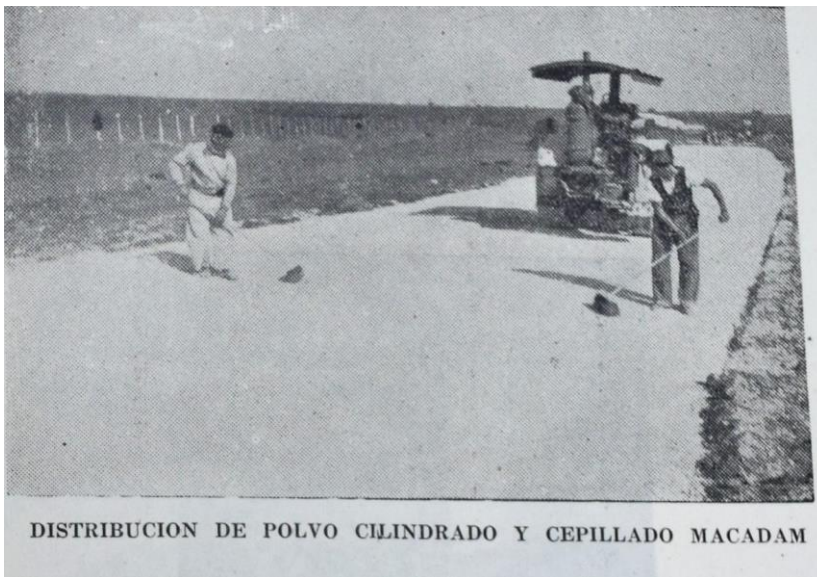
Imagen 2. Construcción de caminos, 1947.
