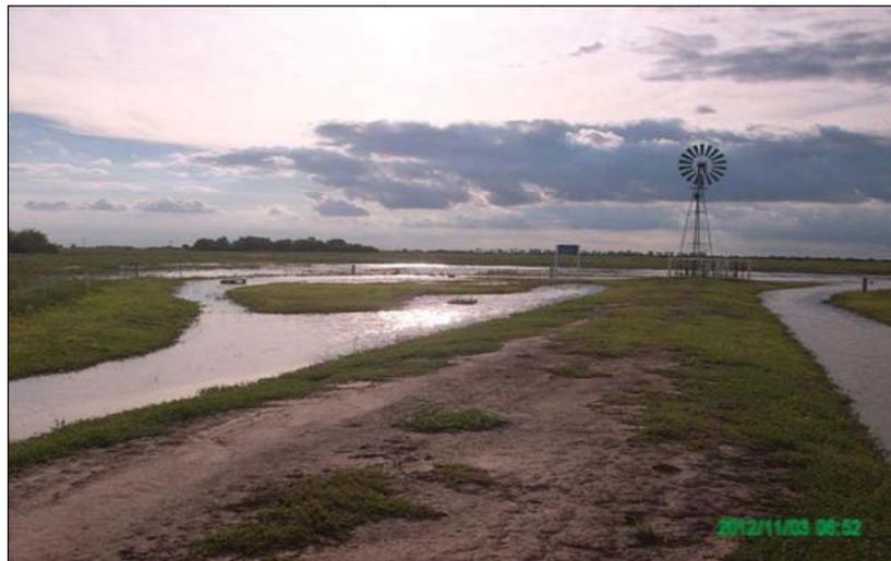
Figura 4. Sistematización del camino de acceso de doble propósito: tránsito y “cosecha” de agua de lluvia.
