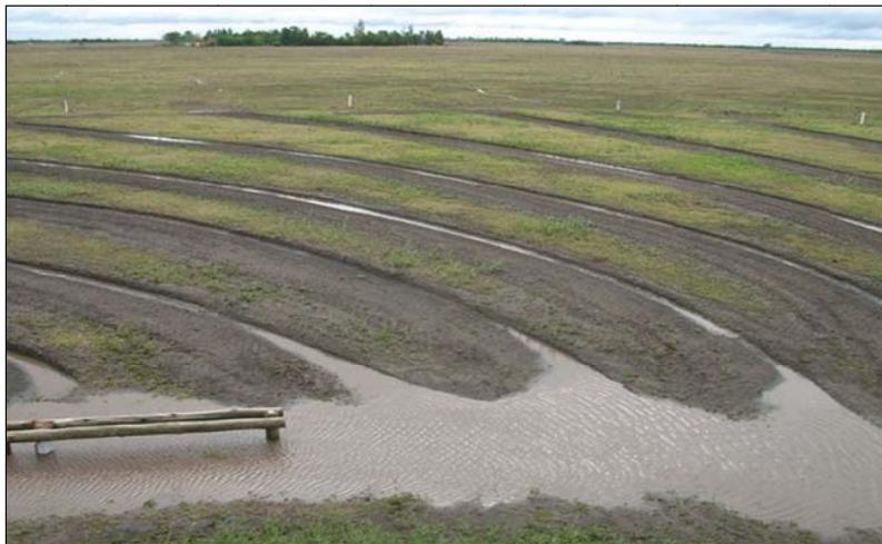
Figura 10. Área de captación actual del Sistema C compuesto por colectoras radiales helicoidales. Diseño: Lahitte, A.
