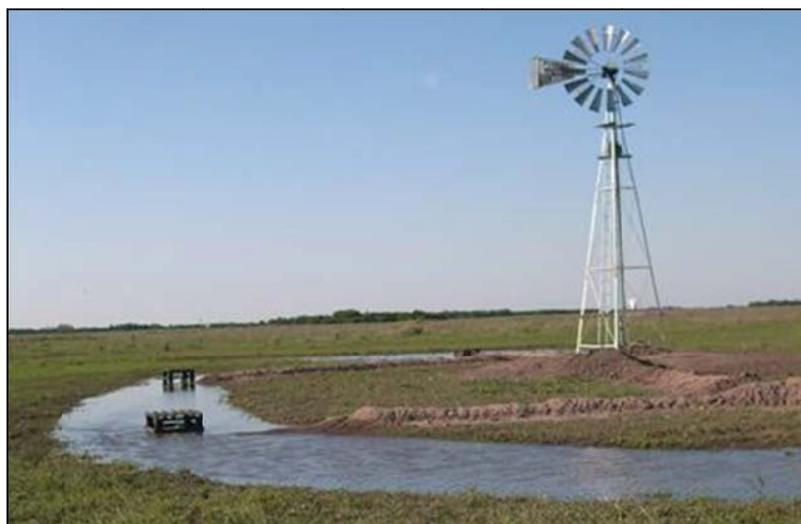
Figura 3. Sistematización del terreno con un canal en forma de plato para inducir el agua de las lluvias a cada uno de los puntos de recarga.
