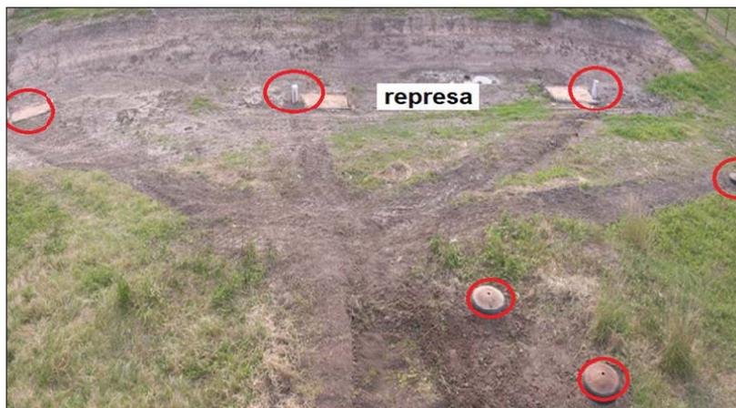
Figura 7. Disposición actual de las 3 perforaciones doble propósito dentro de la represa con chupadores flotantes más las 3 perforaciones convencionales que conforman el sistema “patas de araña” del Sistema B.
