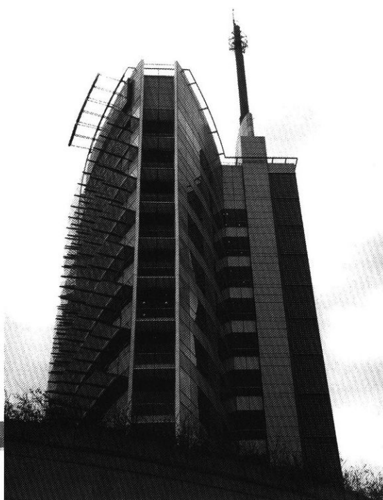
Fig. 3. Torre Malacón, Puerto Madero, Buenos Aires.
