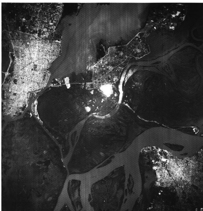
Página anterior: corredor vial Puente Oroño/La Guardia, (fuente: Municipalidad de la ciudad de Santa Fe). Arriba: área metropolitana Santa Fe/Paraná, (fuente: banco de datos FADU/UNI).
