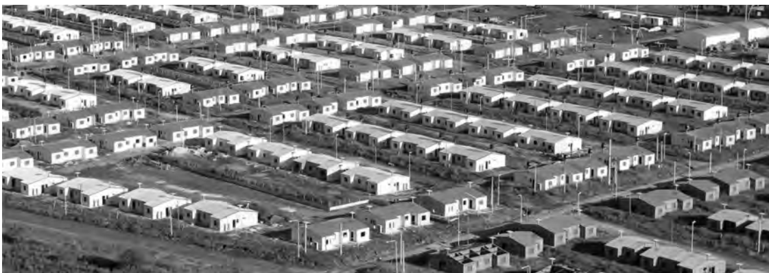
En el área de Colonia Avellaneda, Entre Ríos, el IAPEV habilitó 600 viviendas en 2011 y está construyendo otras tantas. Imagen: http://www.elobservadordellitoral.com/
