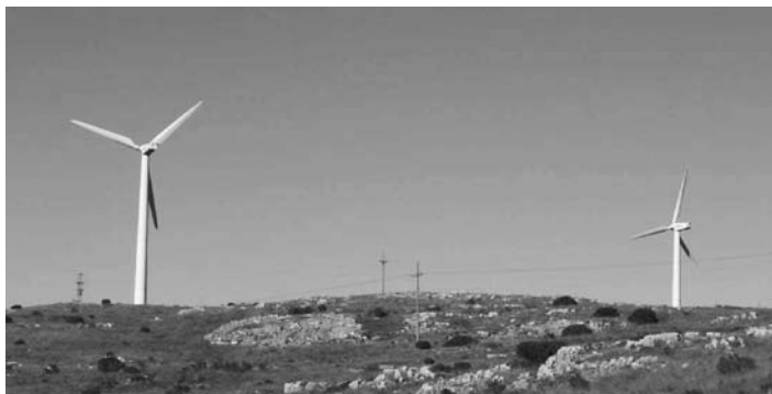
Foto 3. Parque eólico de la CRETAL
