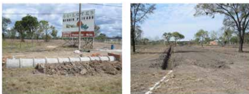
Figura 7. Desarrollo de obras de infraestructura en el barrio cerrado “Río Manso”
