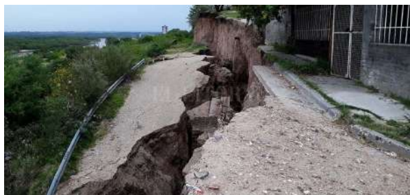
Figura 2. Deslizamiento de suelo octubre 2018. Barrio Urquiza.
