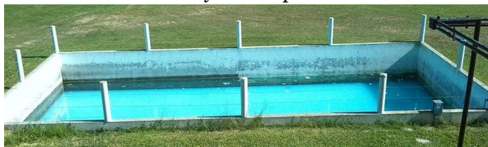
Figura 4: Pileta de recuperación de agua de lavado
