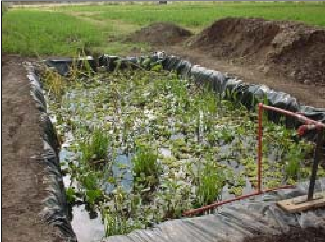
Fig. 1.2. Aspecto que presentó el humedal construido a escala reducida al comienzo de su estudio.
