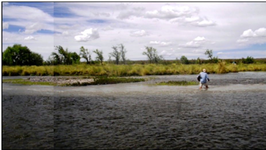
Fig. 7.16. Bancos de grava centrales en el cauce principal formados por la crecida de julio de 2006.
