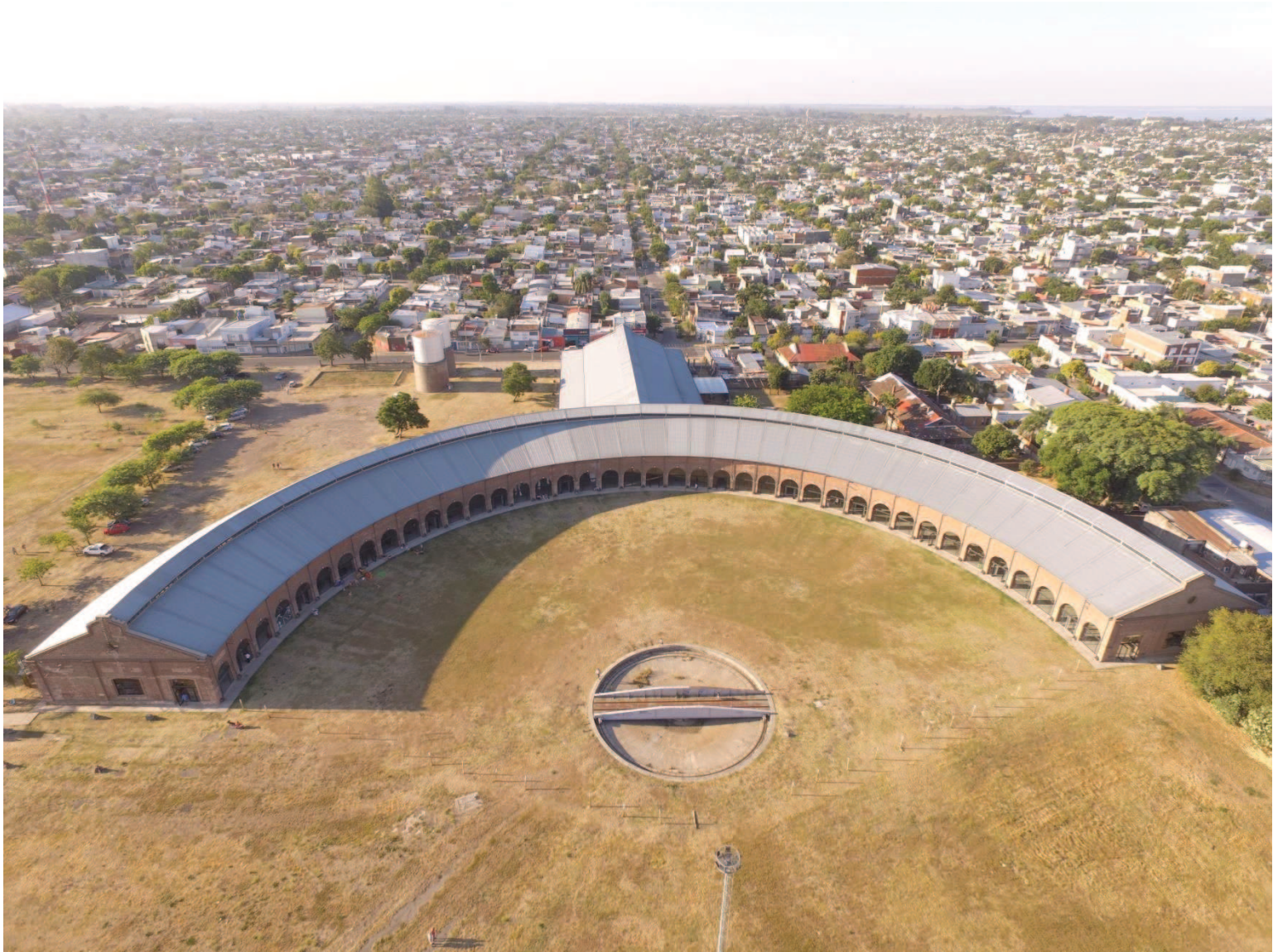
15 Refuncionalización del edificio La Redonda. Foto: Arquitecto Luis Müller
