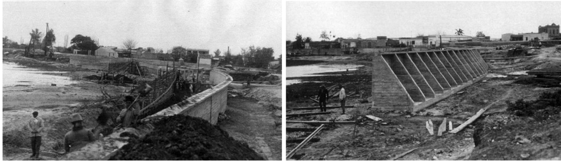
Figura 4.45. La construcción de la Avenida Costanera de Gualeguaychú (fuente SPMG)
