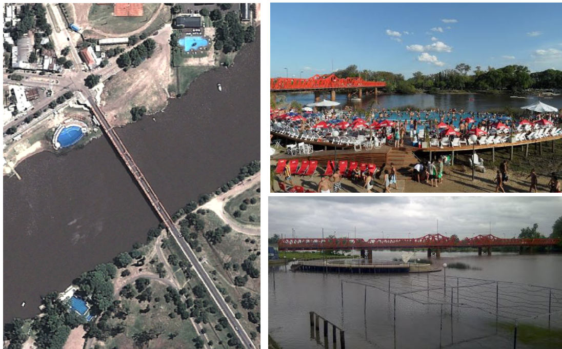
Figura 4.46. Imágenes de la construcción de piletas junto a la costa del río
