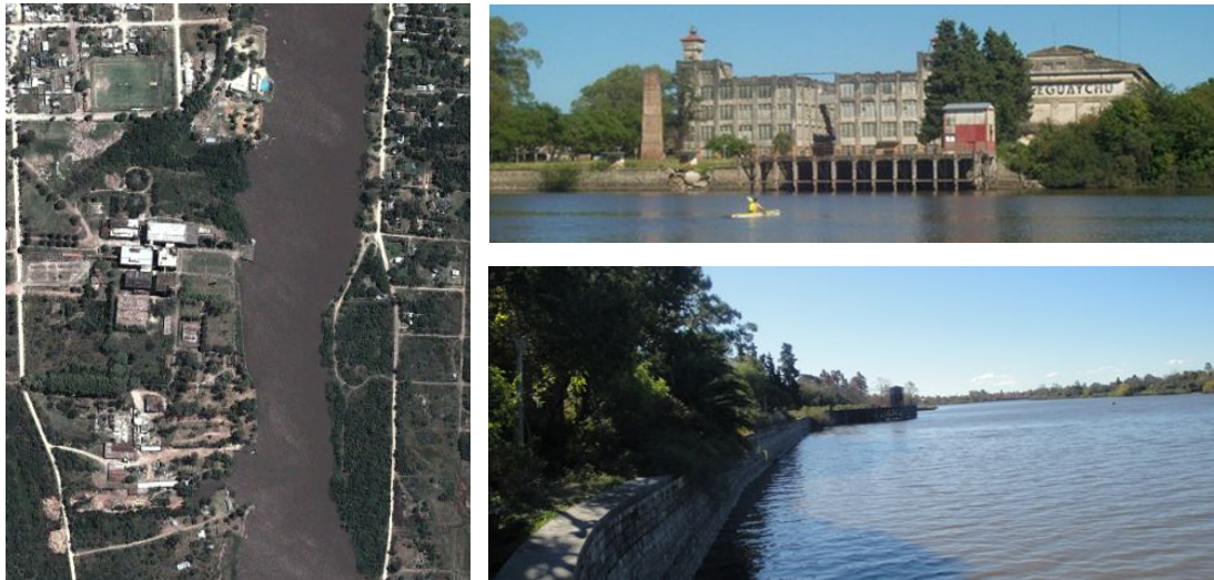
Figura 4.41. Imágenes del antiguo Frigorífico de Gualeguaychú
