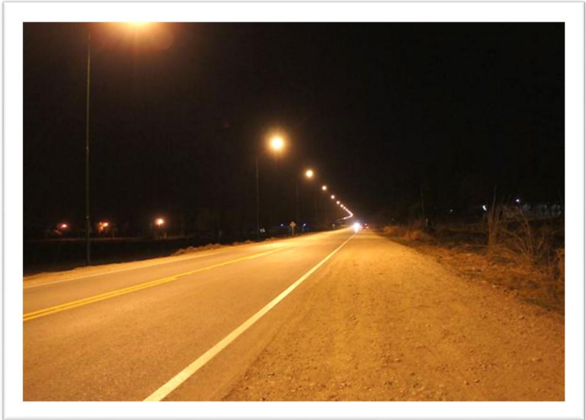
Figura 11. Alumbrado Público instalado en el tramo de la Ruta Provincial N° 24 que conecta la circunvalación con el empalme a la ruta, camino a Paraje Las Blancas.
