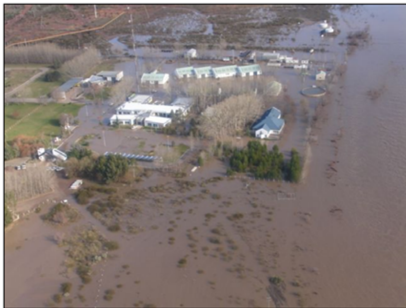
Fig. 5.10. Crecida de 2006 en instalaciones administrativas de Loma de la Lata.
