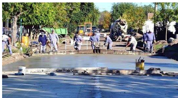
Figura 4.16. Ejecución de pavimento de hormigón armado
