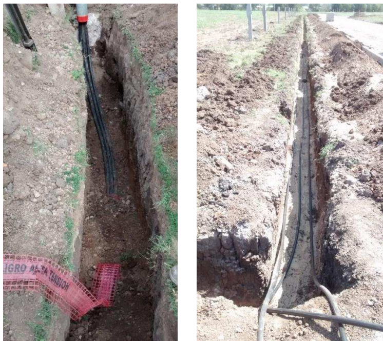
Figura 4.21. Tendido de cable subterráneo
