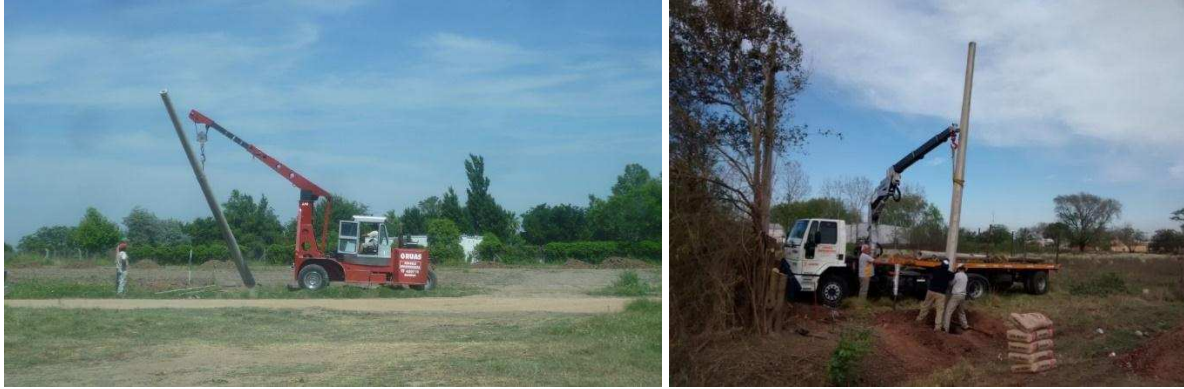
Figura 4.24. Instalación de columnas de H°A°
