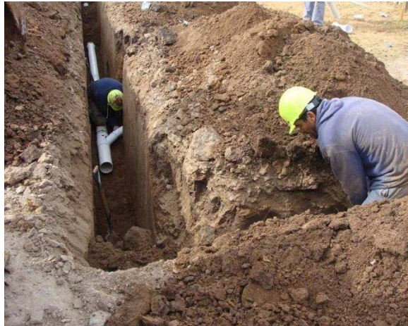
Figura 4.18. Tendido de cañerías de PVC de red de desagües cloacales
