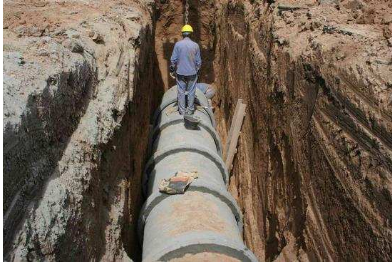
Figura 4.22. Entubado para red de desagüe pluvial mediante caños de H°A° premoldeado
