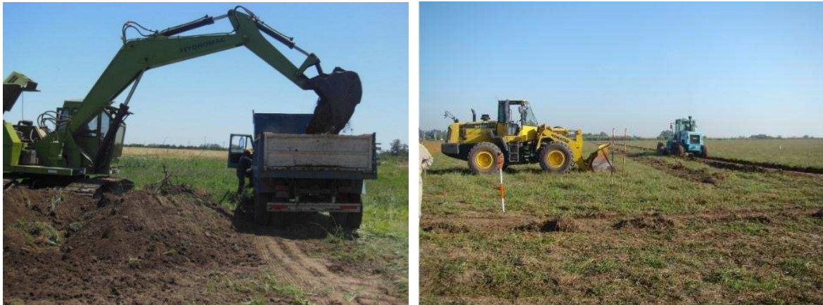
Figura 4.12. Movimiento de suelos para apertura de calles. Extracción de suelo vegetal
