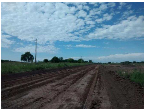
Figura 4.13. Movimiento de suelos para apertura de calles. Aproximación de niveles de sub-rasante
