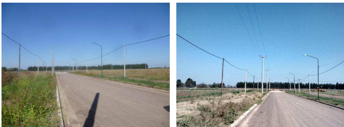
Figura 4.27. Tendidos aéreos de redes eléctricas y alumbrado público
