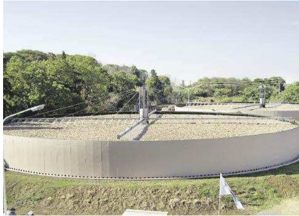
Figura 4.38. Vista de los lechos percoladores de la planta de tratamiento de líquidos cloacales
