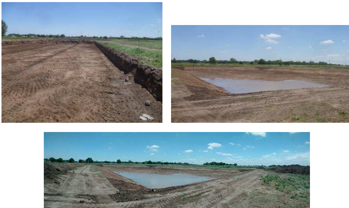
Figura 4.10. Excavación correspondiente a una laguna de retardo y perfilado de sus bordes
