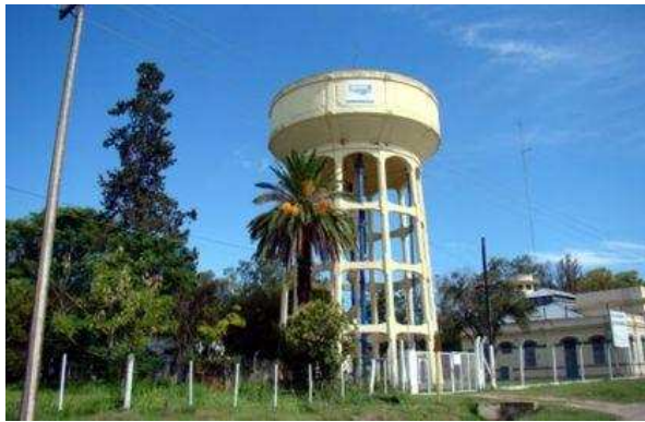
Figura 4.30. Tanque elevado de la planta de tratamiento de agua potable Rafaela
