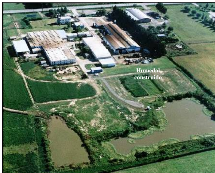
Fig. 6. Foto aérea del humedal construido en la planta metalúrgica.
